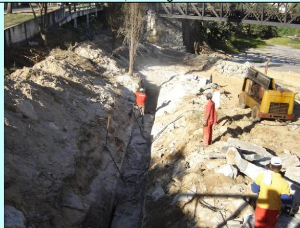
Fig. 14- Corte feito por lança térmica em rochas gnáissicas do embasamento na Ponte de Ferro para canalização do esgoto no ano de 2007, Formiga- MG
