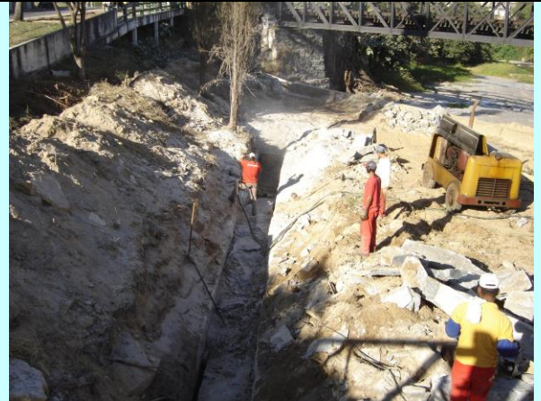
Figura 14- Corte feito por lança térmica em rochas gnáissicas do embasamento na Ponte de Ferro para canalização do esgoto no ano de 2007. Pontilhão de Ferro, Formiga- MG
