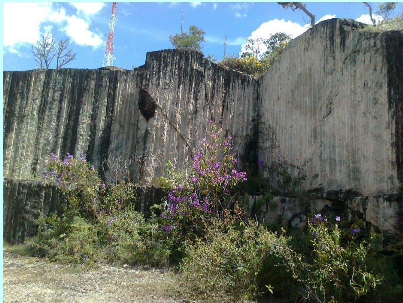
Figura 16- Frente de lavra abandonada no Morro da Melancia. São migmatitos entrecortados por diques granitoides.
