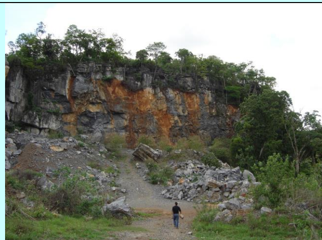
Figura 72- Frente de lavra de calcário. Notar a vegetação que se desenvolve sobre o maciço. Córrego Fundo- MG
